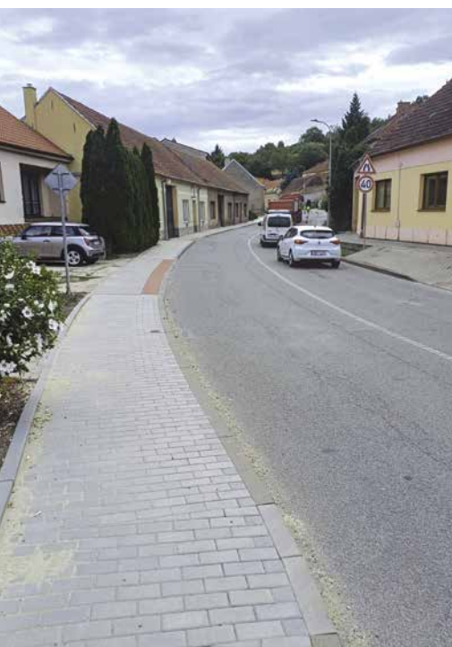
Oprava chodníku v ulici Komenského
