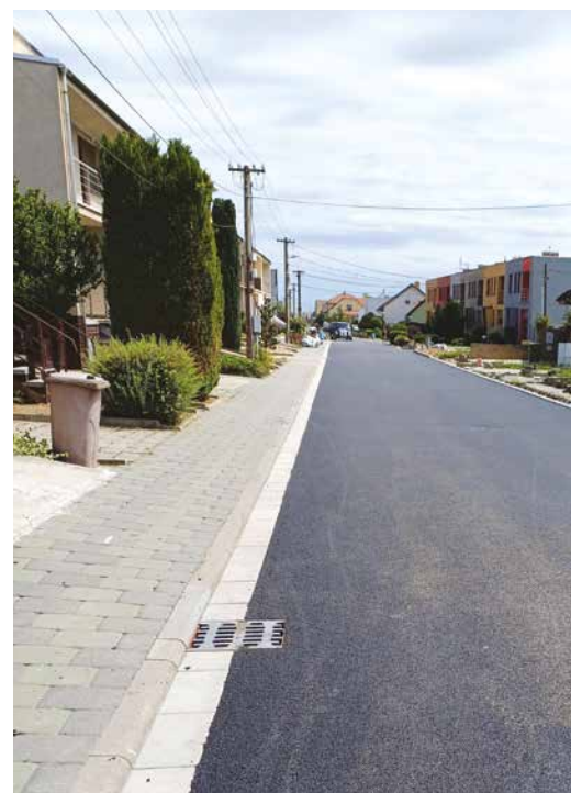
Nový asfalt v ul. 9. května
